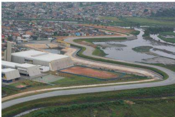
Dique e piscinão no Jardim Romano
